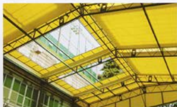
施工例：工場荷捌き場
