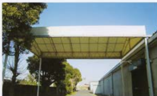
施工例：工場荷捌き場
